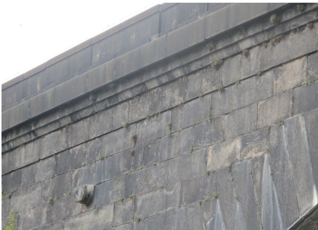
5. Římsa a kamenné zábradlí
